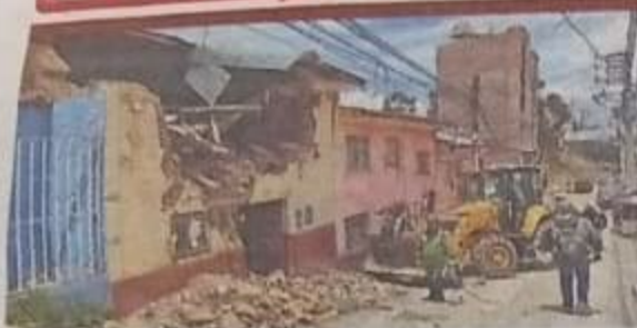
Inician demolición de predio.
